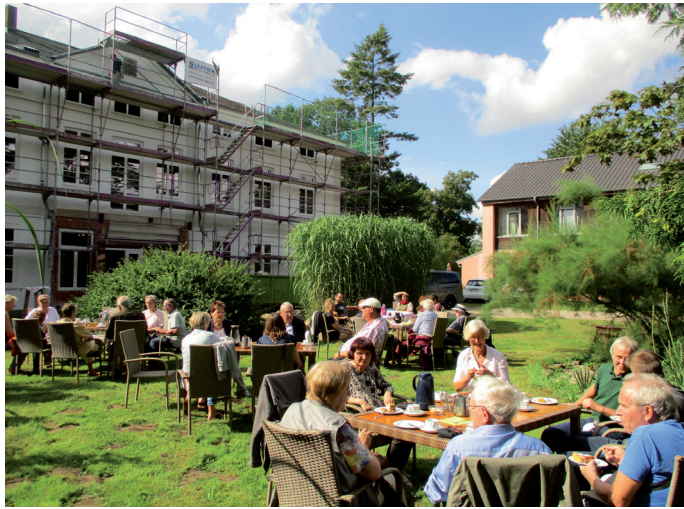
2022 wurde die Vorderfassade des ehemaligen Gutshauses unter reger Anteilnahme der Nachbarn saniert
