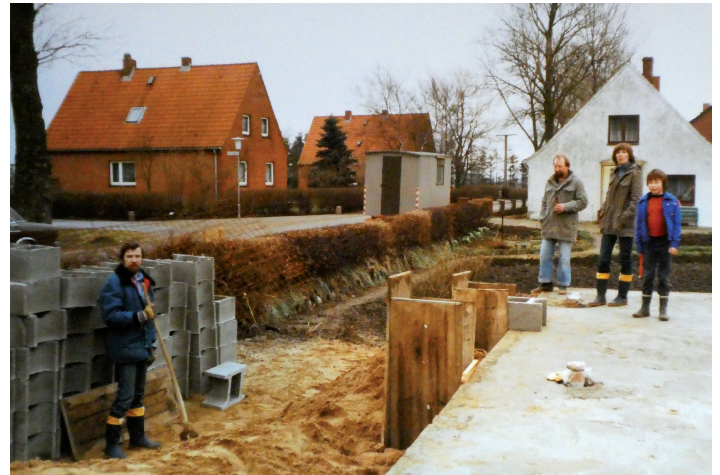
Ende März 1982 war die Bodenplatte fertig
