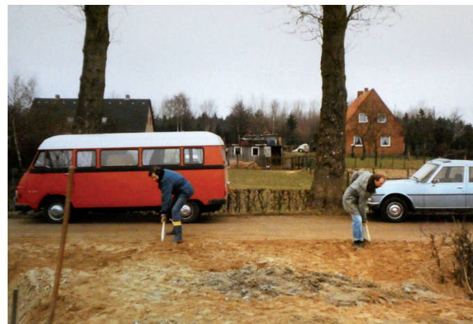
Baubeginn Anfang März 1982
