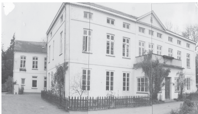
Hier lebten um die 80 Kinder mit ihren Betreuerinnen im ehemaligen Gutshaus. Links das Wirtschaftsgebäude mit der Großküche
