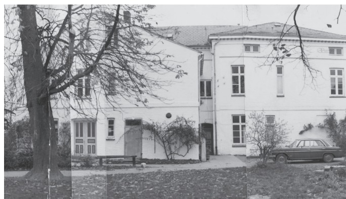
Südsicht des Althaus mit Eingang zur Küche
