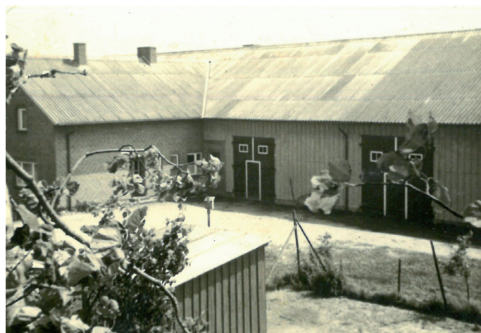
Rechts im Bild die Erweiterung der Scheune. Foto 1965
