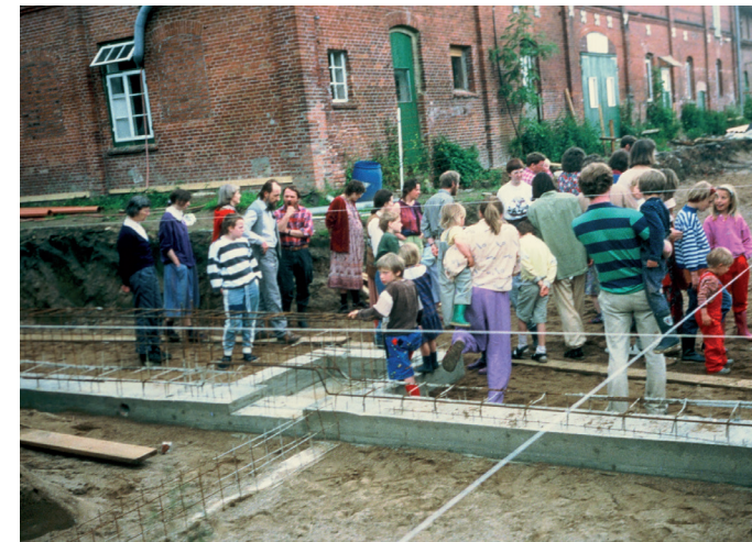
Im Herbst 1991 sind erste Fundamente der Halle auf der Südseite fertiggestellt
