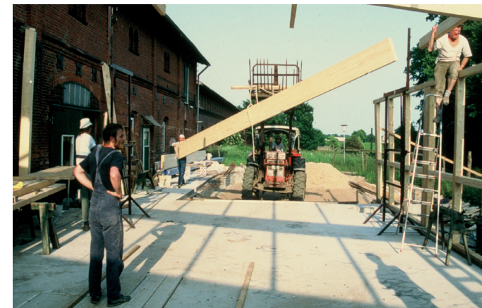
Auf die Bodenplatte wird im Sommer 1992 die Rahmenkonstruktion für die Maschinenhalle gestellt
