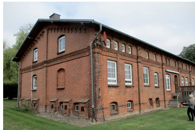
Blick von Südwest mit Kellerfenstern, 2024
