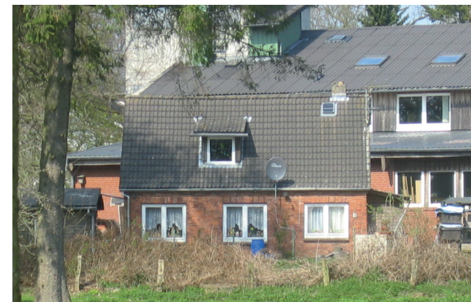
Ansicht des ehemaligen Gärtnerhauses von Süden 2009
