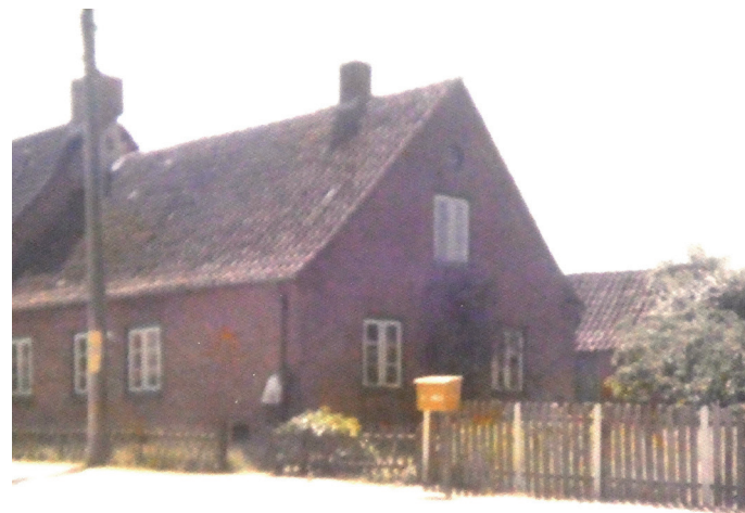
Das „Dreikronenhaus“ um 1973. Der hintere östliche Teil des Gebäudes war bereits erneuert worden, ist deshalb höher als der westliche alte Rest der Kate
