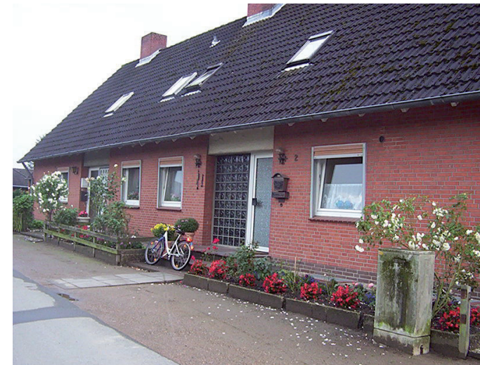
Der Neubau des „Dreikronenhauses“ 1968/1974 im Jahr 2009
