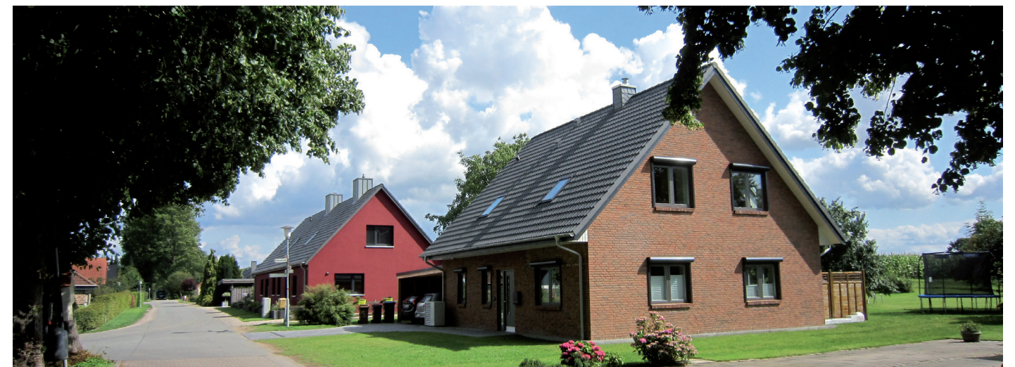
Heutige Ansicht. Das Dreikronenhaus mit neuem Anstrich im Hintergrund. Vorn der Neubau am Platz des ehemaligen Schweitzerhauses
