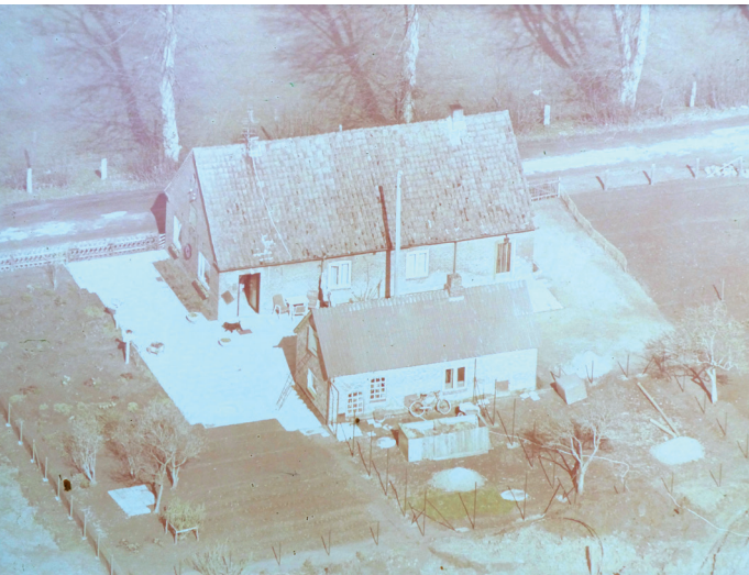
Luftbild des Grundstückes Kattunbrook 6 um 1960
