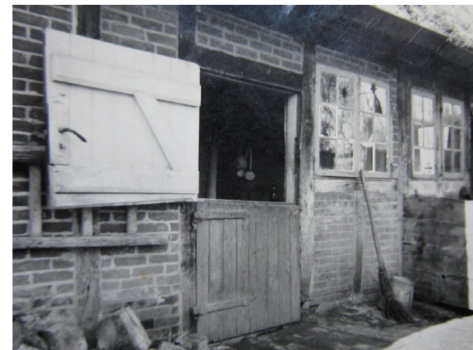
Haustür der Familie Kühl auf der Hofseite des Gebäudes
