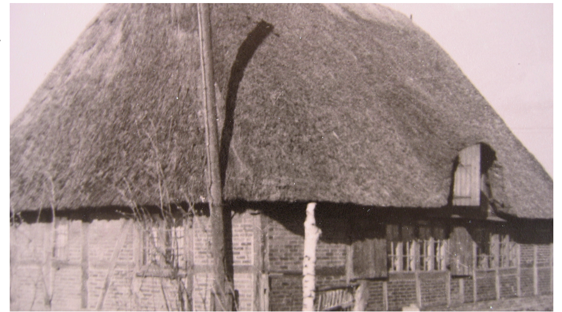
Aufnahme von Peter Brott, 1956. In der Mitte des Fotos ist der Strommast für die Küchenbeleuchtung zu sehen
