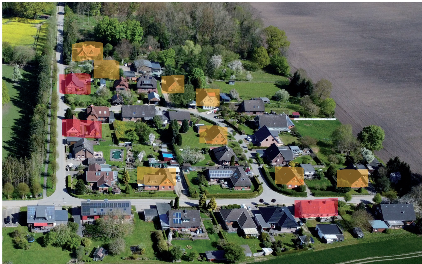
Unten: Luftbild von Wulfshagenerhütten 2025 ROT sind die ehemaligen Landarbeiterkaten von 1840 und 1890 markiert. GELB sind die Nebenerwerbssiedlungen von 1959 markiert.
