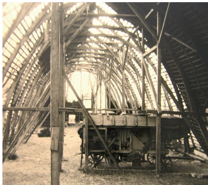
Abbruch der Walscheune 1958. Im Bild die Dreschmaschine
